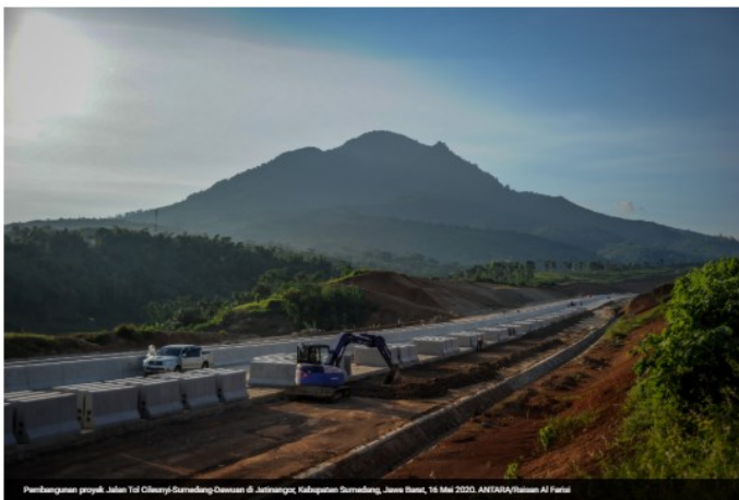
Pembangunan proyek Jalan Tol Cileunyi-Soreang-Dewati & Jatinagara, Kabupaten Soreang, Jawa Barat, 16 Mei 2020. ANTARA/Helmi Al Fatah
